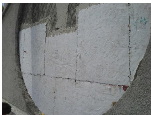
Etapă intermediară de montare
